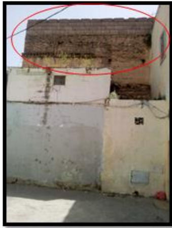
الصورة رقم 01: تدخلات على مستوى المباني بمواد حديثة.
